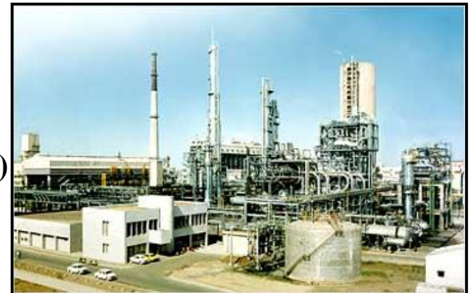
Anlage zur NH 3 -Produktion
