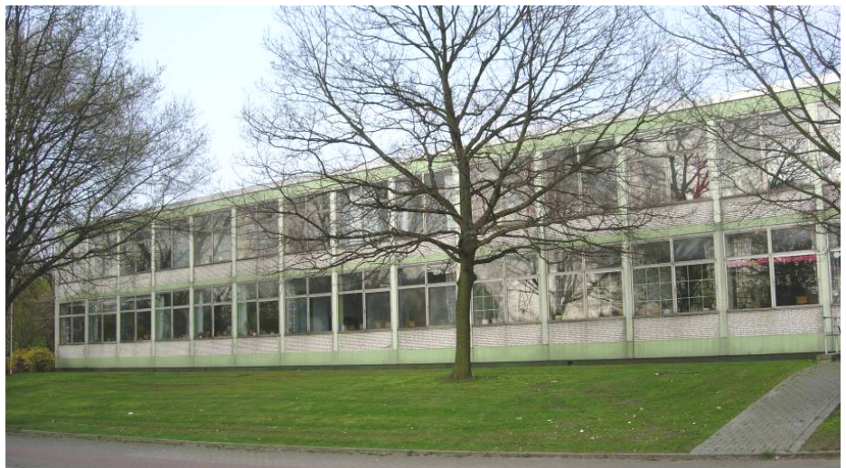
Ansicht auf die Gustaf-Adolf-Schule vor Sanierung
