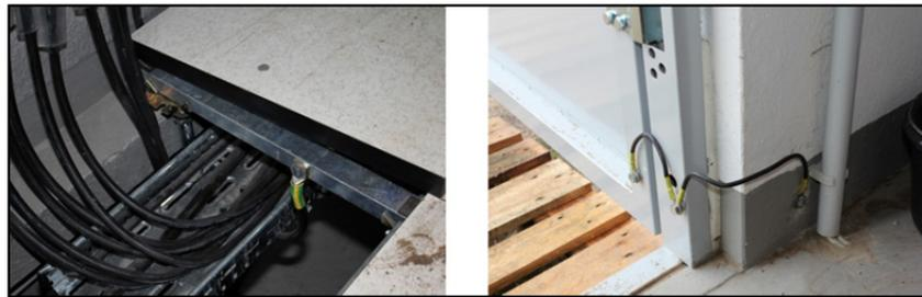
**Bild 2** Erdungen von Doppelboden und Tür
