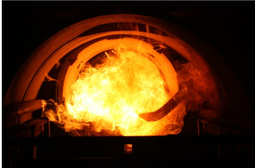
Abbildung: Brennraum Biomassekessel (Brennstoff Gärrestpellets)
