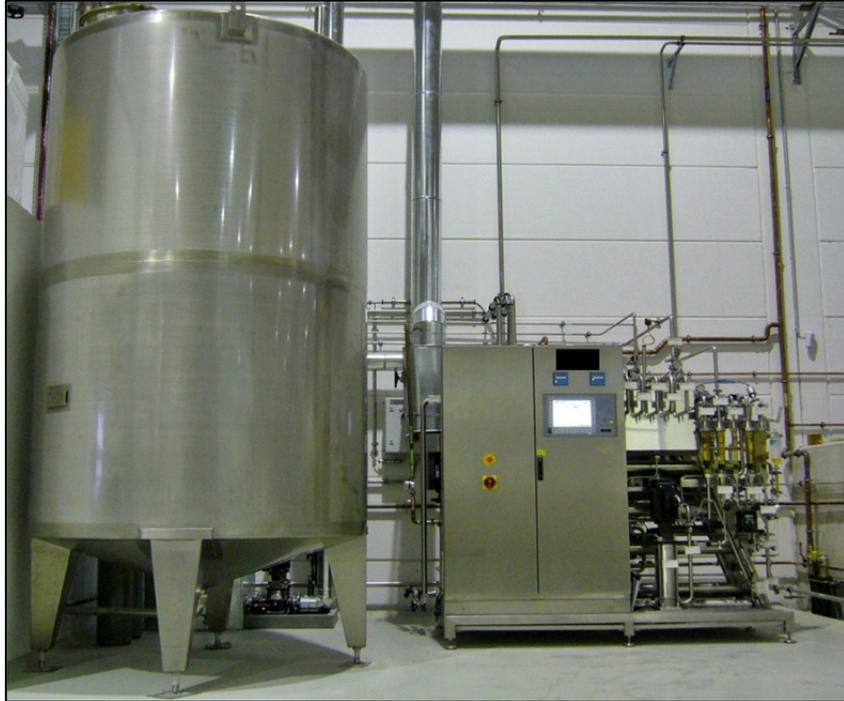
Bild: Aufbereitungsanlage für Pharmawasser
