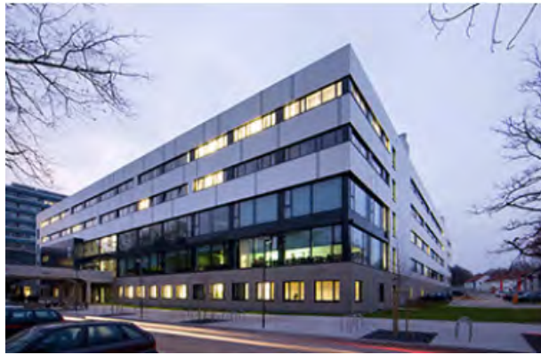
Abb. 1 Außenansicht des Gebäudes ID
