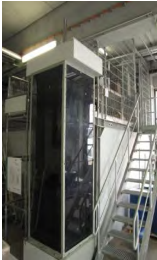
Fallschacht am Fraunhofer Institut UMSICHT
