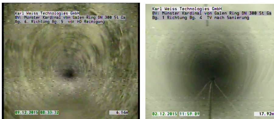
Abbildung 5 Dokumentation des Gewebeschauchrelinings vor und nach dem Einzug
