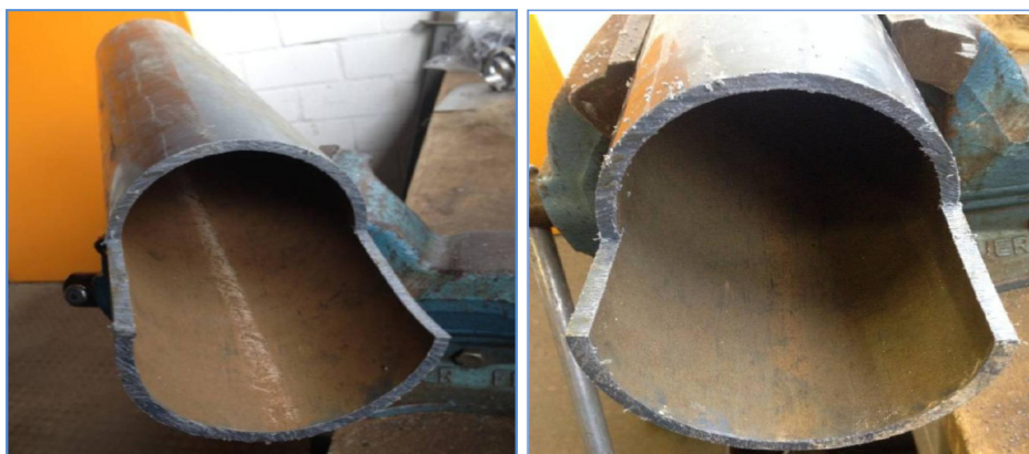
ABBILDUNG 1: AUSGEBAUTE ROHRSTÜCKE VOR UND NACH DER WASSERSAUGSPÜLUNG.
