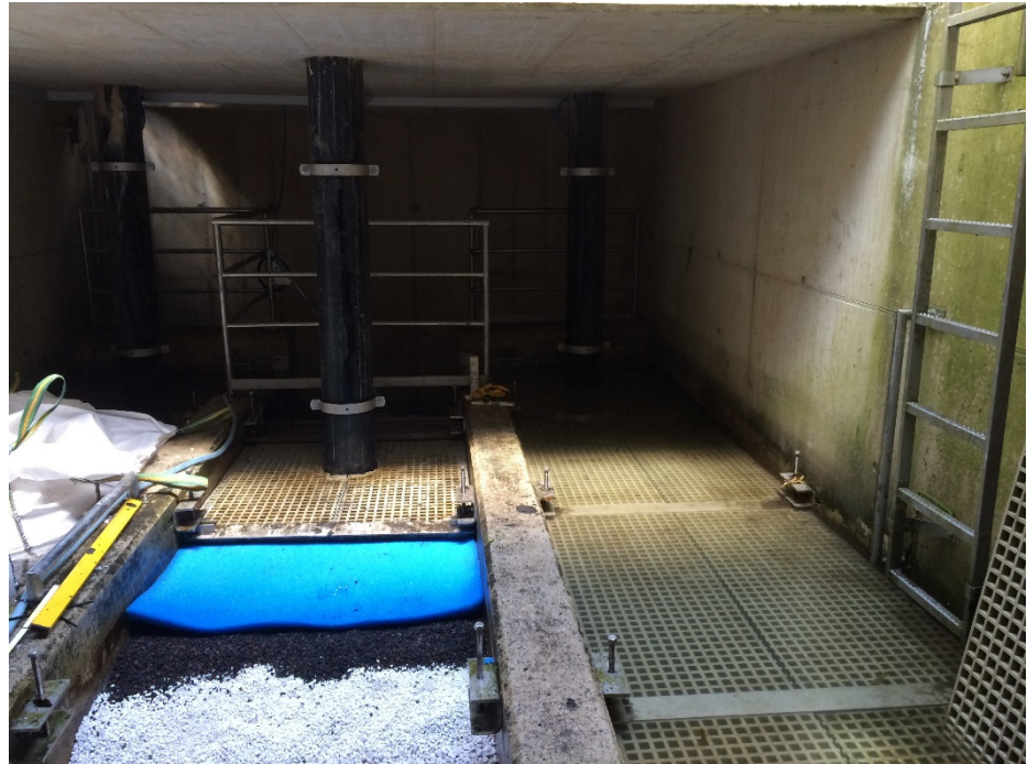
Bild 1: Einbau des Filtermaterials in den technischen Regenwasserfilter
