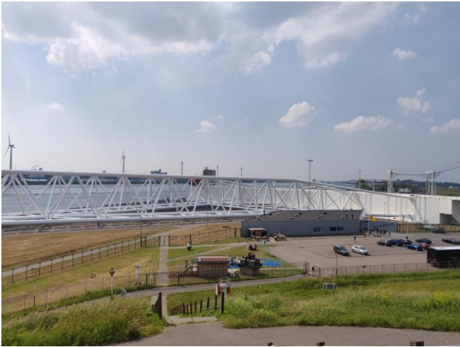
Nördliches Tor des Maelant-Sperrwerkes (Foto: R. Mohn)
