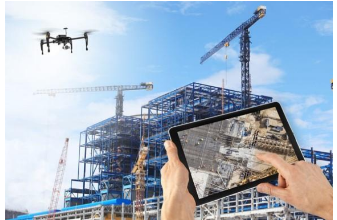
Drohnenüberflug einer Baustelle (EXPO UAV, 2019)
