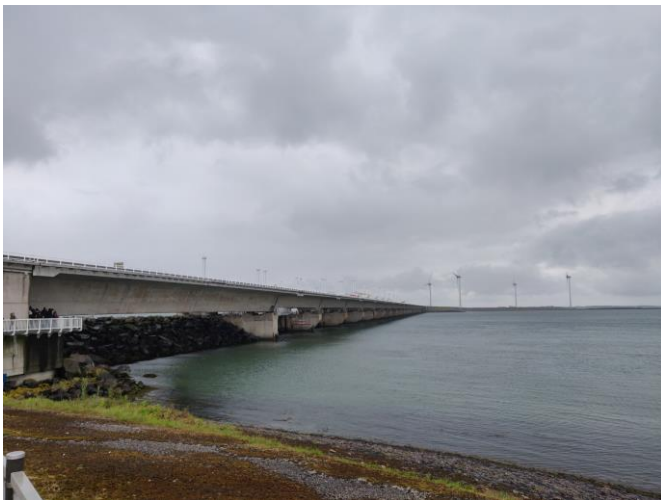
Teil des nördlichen Oosterschelde-Sturmwehrs (Foto: R. Mohn)
