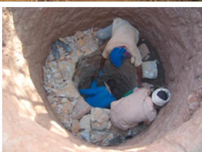
Äthiopische Arbeiter beim Bau der Brunnenanlage
