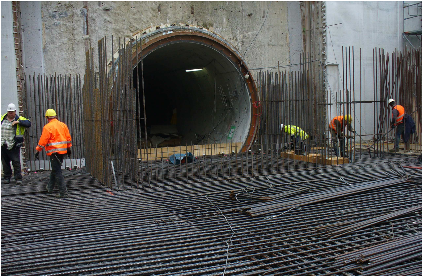
Großbaustelle „Röntgenlaser XFEL“: Das Foto zeigt eine von zehn Tunnelröhren, die in die Experimentierhalle münden
