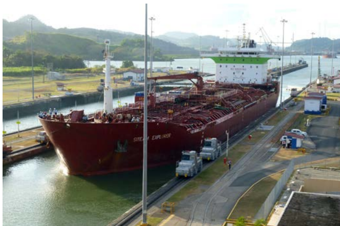
Einfahrt eines Tankers in die obere Kammer der Miraflores-Schleuse
