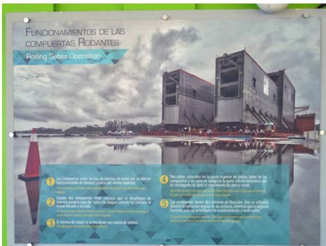
Die stählernen Rolltore der Schleusen während der Bauphase, Plakat mit Funktionsbeschreibung im „Canal Expansion Observatorium“ (Panama Canal Authority)
