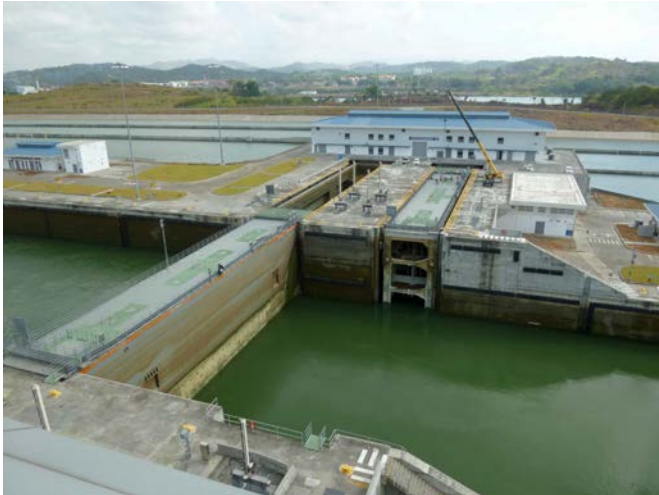
Doppelte Rolltore (an sämtlichen Kammerenden), hier zwischen der oberen und mittleren Schleusenkammer, das zweite Tor dient als Reservetor für Störfälle und Wartungsarbeiten
