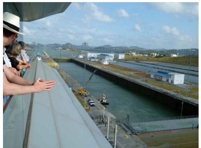
Blick vom Kontrollturm der Cocoli-Schleuse auf die obere, landseitige Schleusenkammer und rechts davon auf die zugehörigen drei Sparbecken
