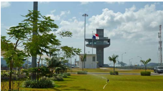
Schleusengelände mit Kontrollturm
