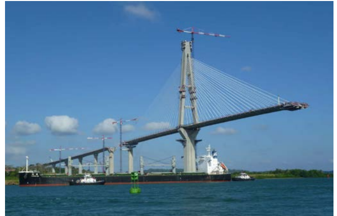
Schrägseilbrücke „Atlantic Bridge“, westliche Hälfte, Bauzustand 06.03.2018
