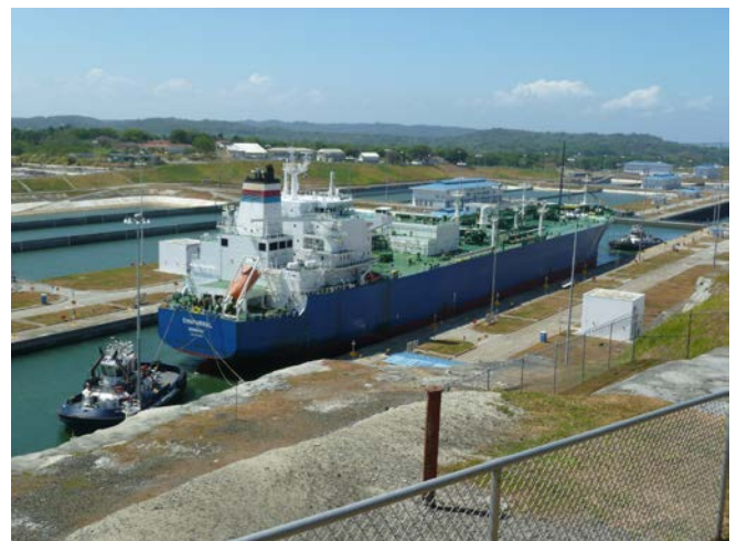
Tankschiff in der obersten Kammer der Agua-Clara-Schleuse, geführt durch zwei Bugsierschlepper
