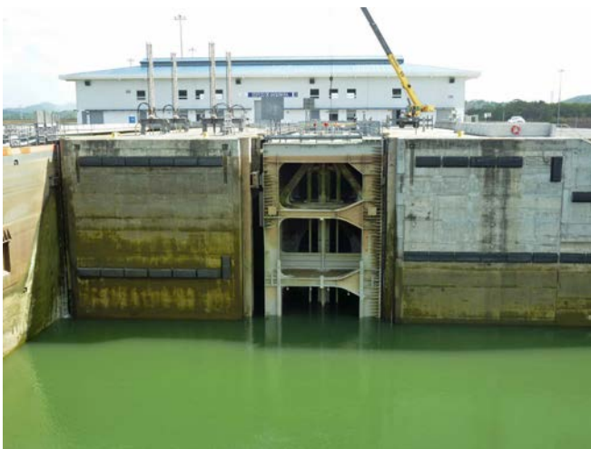
Blick auf ein eingefahrenes Reserve-Rolltor
