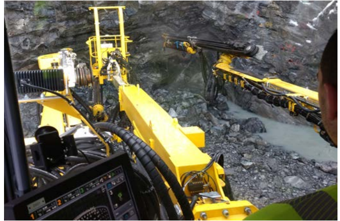
Trotz Automatisierung werden die Bohrungen überwacht
