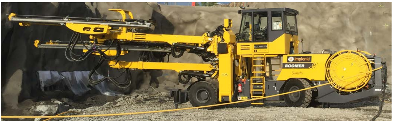
Ein mobiles Vortriebsbohrgerät zum Bohren von Sprenglöchern im Einsatz
