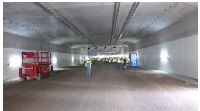
Der Tunnel Stellingen
