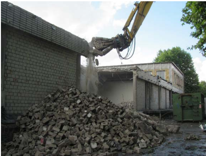
„Eine Variante bei Erreichen des Mindest-Soll-Zustands: Abriss“
