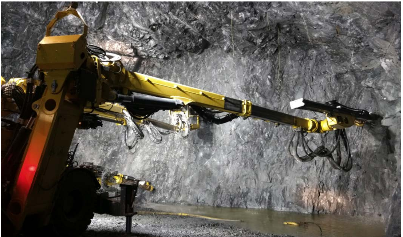
Bohrarbeiten für die Sprenglöcher an der Ortsbrust
