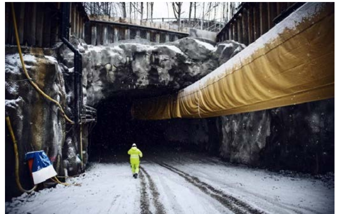
Dieser Zugangstunnel wird nach Bauabschluss wieder verfüllt
